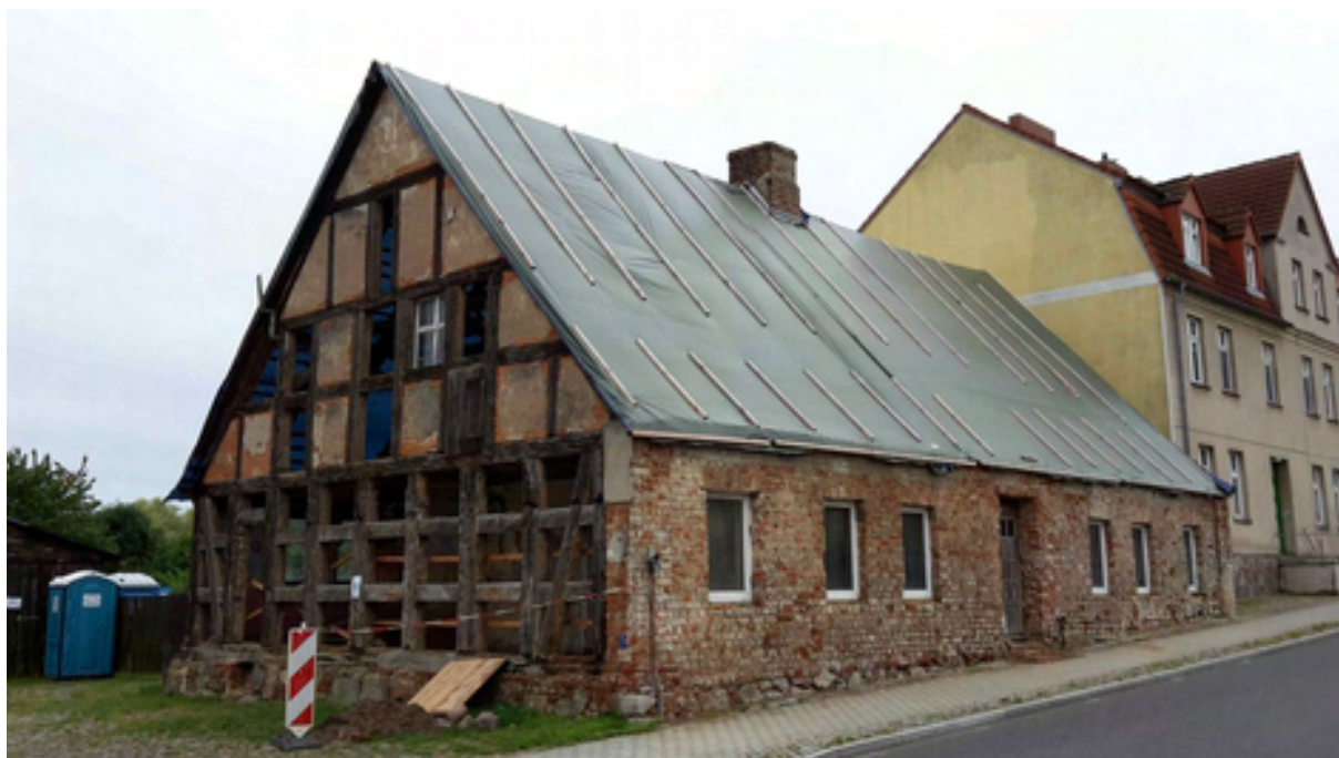
Ziegelwand der Straßenfront
