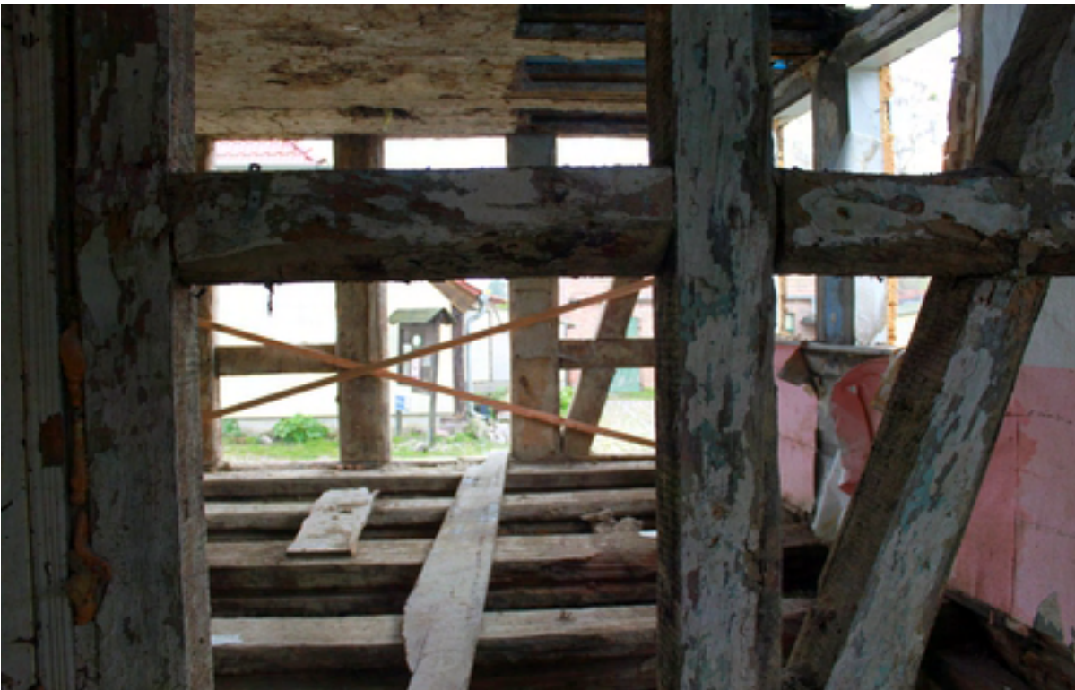
Freigelegte Balkenkonstruktion im Inneren des Hauses (Oktober 2017)
