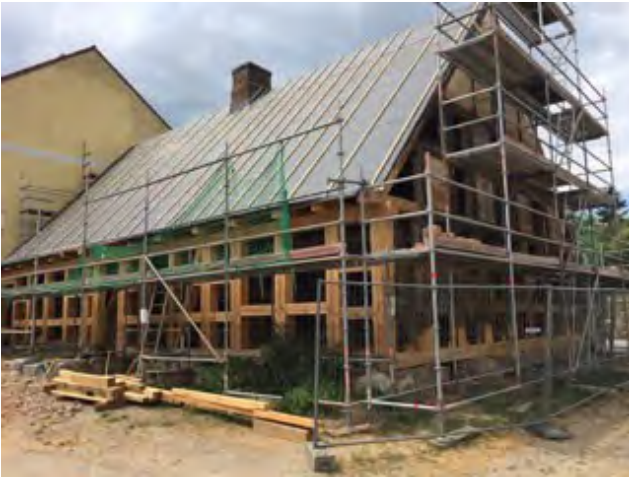
Fertigstellung der Dachunterkonstruktion. Foto: R. Vögel am 18. Juni 2018
