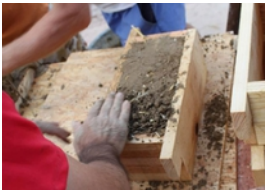
Herstellung von Lehmziegeln
