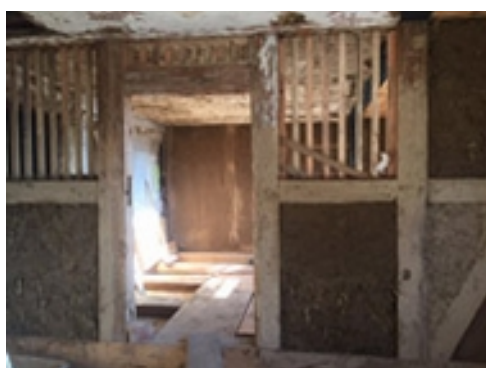
Traditionelle Lehmstakengefache im Hausinneren. Foto: R. Vögel
