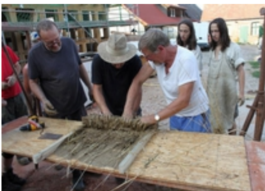
Wickelstaken werden mit Lehm und Langstroh hergestellt
