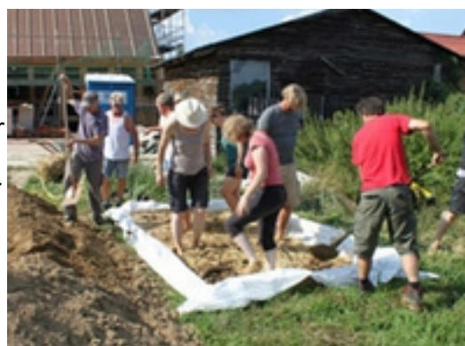
Der Lehm wird mit Wasser und Stroh vermischt und in eine verarbeitungsfähige Konsistenz gebracht.
