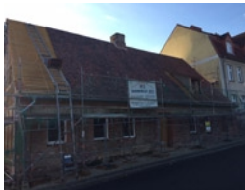
Nordseitig, Ziegeleindeckung des Gebäudes. Foto: R. Vögel
