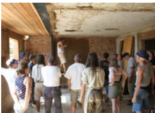
Herr Bocian gibt eine Einführung in die Techniken des Lehmputzes
