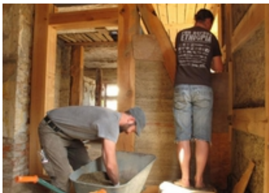
Eine Wand wird mit Stampflehm gebaut
