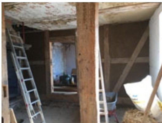
Letzte Verputzarbeiten. Foto: Rudi Vögel
