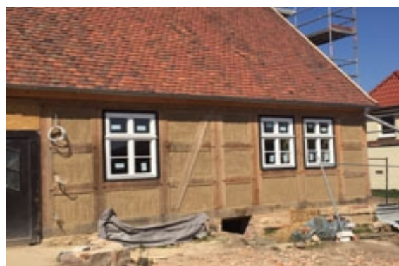
Die neuen Fenster wurden eingebaut. Foto: Rudi Vögel
