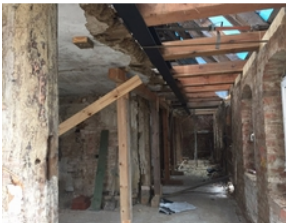
Strassenseite, Sanierung Lehmdecke Sparrenköpfe Bild: R. Vögel
