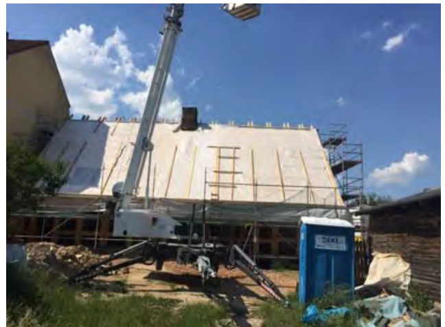
Stand der Arbeiten am 30. Mai 2018. Foto: R. Vögel
