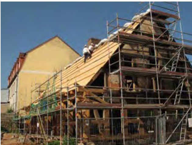
Arbeiten am Dach. Foto: A. Becker am 30. Mai 2018
