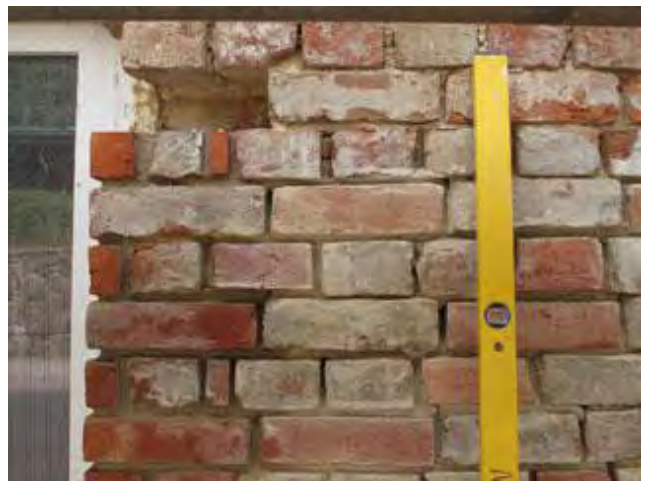
Detailansicht der Mauersanierung. Foto: A. Becker am 2. Juli 2018
