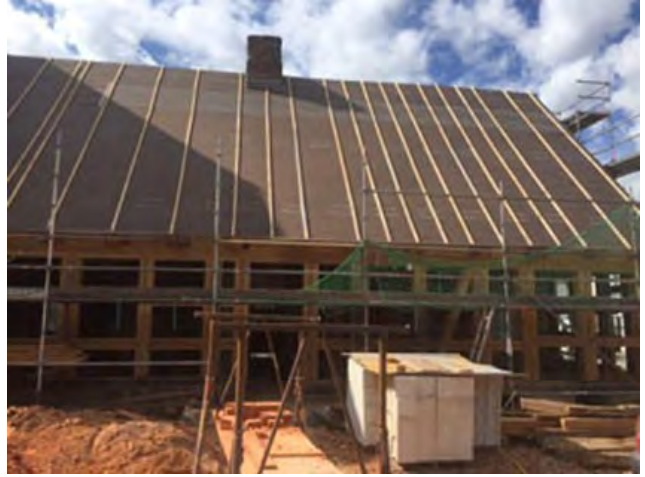
Das Dach ist bereit für die Dachdeckerarbeiten. Foto: R. Vögel am 26. Juni 2018
