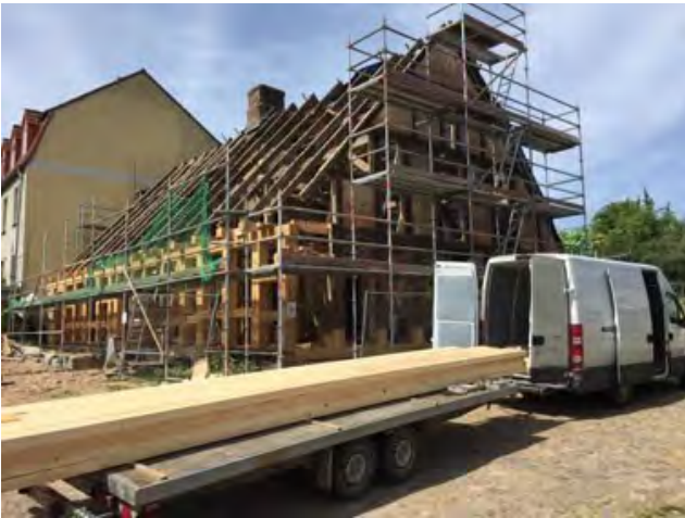
Erneuerung der Balkenkonstruktion an der Südseite. Foto: R. Vögel am 23. Mai 2018
