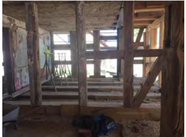
Fertigstellung der Innengefache. Foto: R. Vögel am 30. Mai 2018
