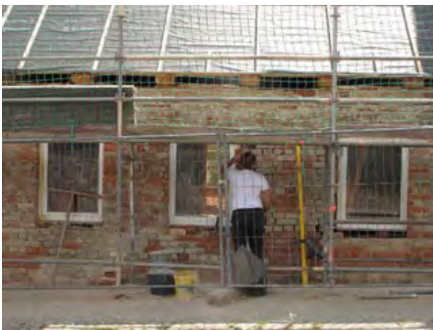
Das Mauerwerk an der Straßenfront wird repariert. Foto: A. Becker am 2. Juli 2018
