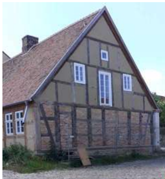
Die Giebelseite zum Hof ohne Baugerüst
