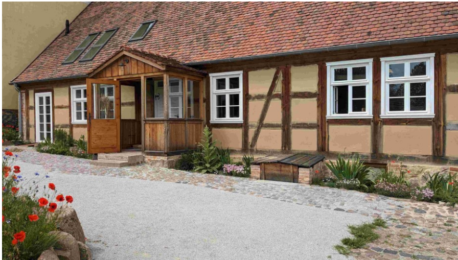
Weg zu den Haustüren wurde gepflastert
